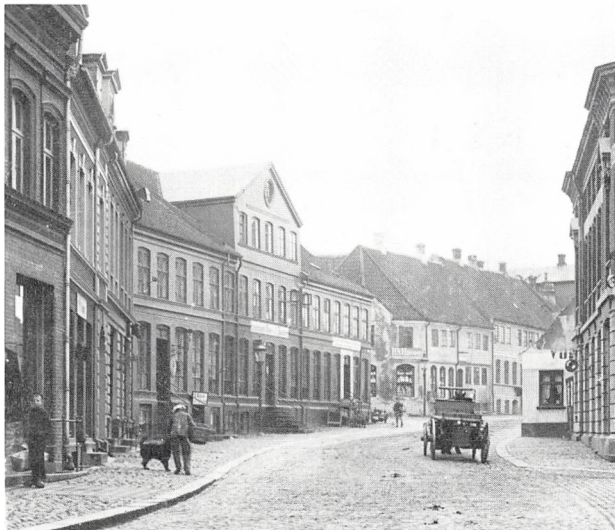
1901. Hjørneejendommens facade mod Låsbygade, set mod vognfabrikkens gavl.
