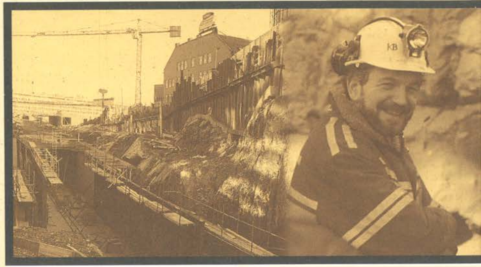
Utbyggingen av hovedveinettet i Oslo og Akershus, den såkalte "Oslo-pakken", omfattes av totalt 50 forskjellige veiprosjekter.
