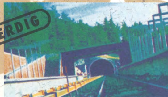
Prosjektet MORTENSRUD T-BANESTASJON
