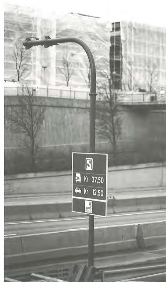
Helautomatisk bomstasjon ved Lysaker.
