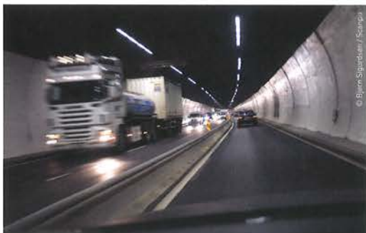
Festningstunnelen skal tilpasses senketunnelen som ligger lavere i terrenget.
