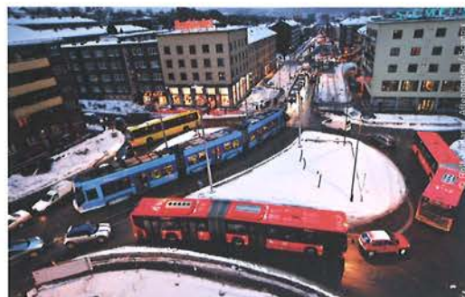
Ombyggingen av Carl Berners plass skal etter planene være ferdig i løpet av høsten 2010.
