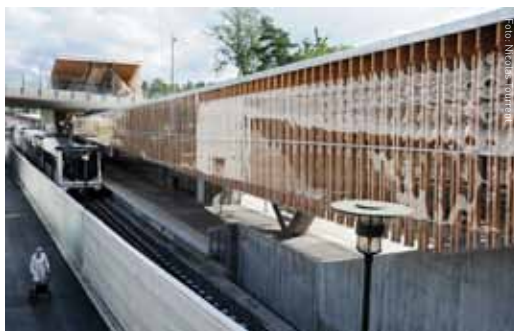
Bekkestua T-banestasjon åpnet i august 2011. Etter planen skal T-banen rekke helt ut til Kolsås i løpet av 2014.
