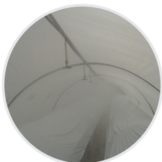
Ejemplo de macro túnel
